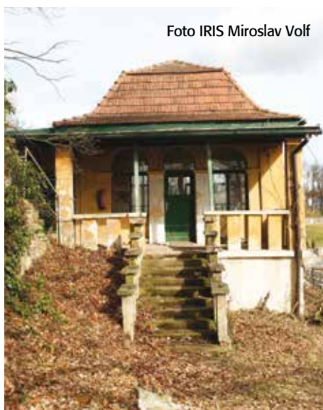
Původní zahradní domek před demolicí.
